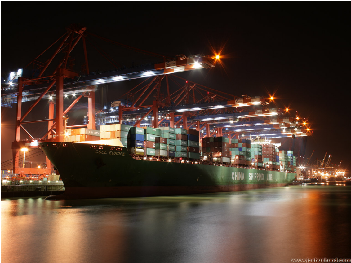
Abbildung 4: Containerbrücken in Hamburg von [Haf08]
